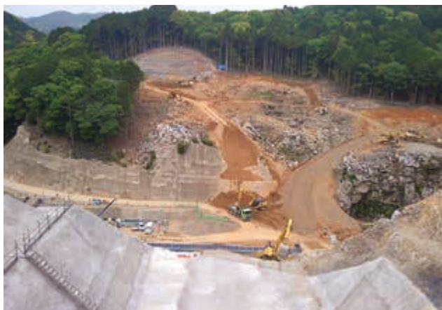
堤体基礎掘削状況
