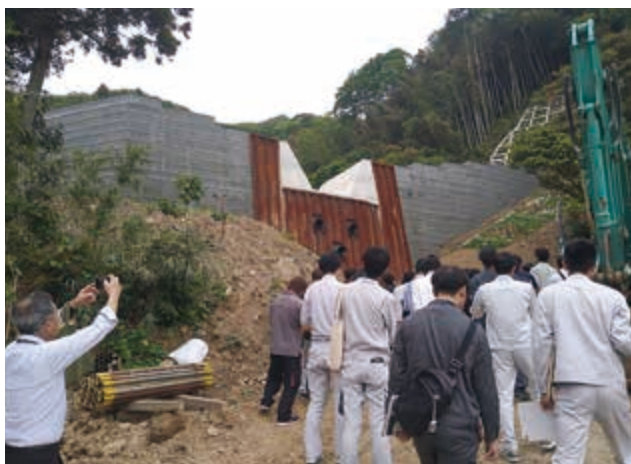
宮谷堰堤（INSEM工法）
